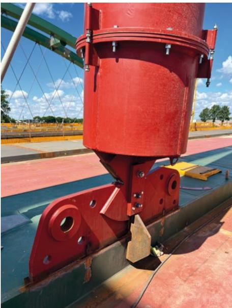
**Bild 18** Unterer Anschlusspunkt für Montagehilfsstütze
