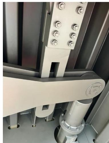
**Bild 12** Steuerstabsystem zur Längskraftabtragung
