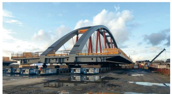
**Bild 16** Hintere Auflagerung auf SPMTs für Aufschieben auf Ponton
