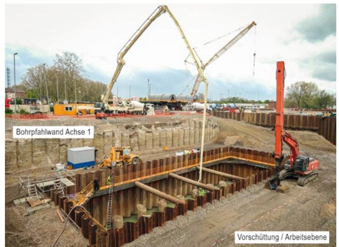
**Bild 6** Verbau temporärer Pfeiler Süd der Ruhrbrücke
