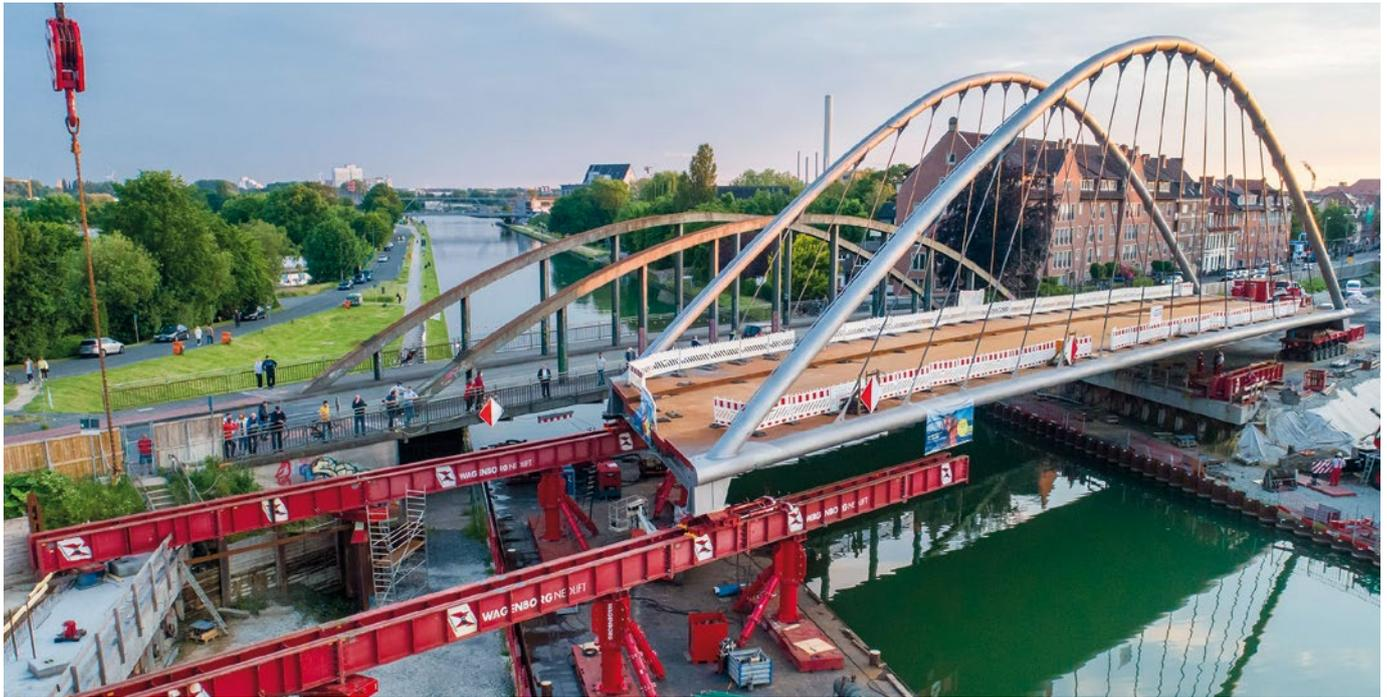
**Bild 1** Abbruch und Neubau der Wolbecker Straßenbrücke über den Dortmund-Ems-Kanal in Münster | Rückbau-, Entwurfs-, Genehmigungs- und Ausführungsplanung und Vorbereitung der Vergabe | Fertigstellung 2023
