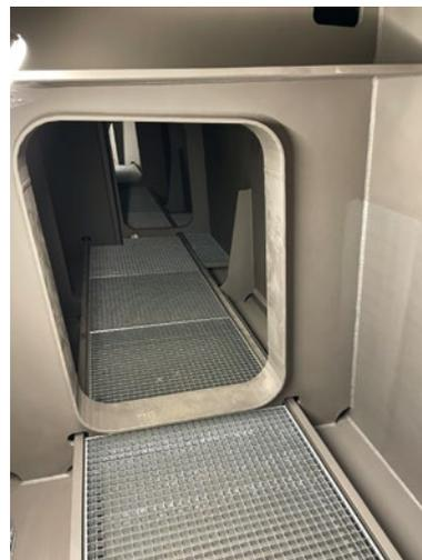
**Bild 14** Besichtigungsgang im Versteifungsträger
