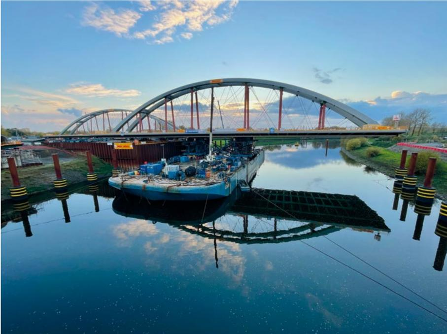
**Bild 17** Einschwimmen Hafencanalbrücke
