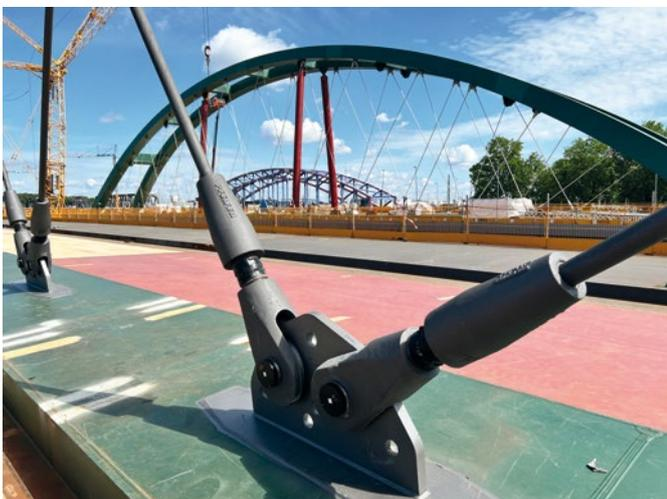
**Bild 11** Untere Seilanschlusskonstruktion
