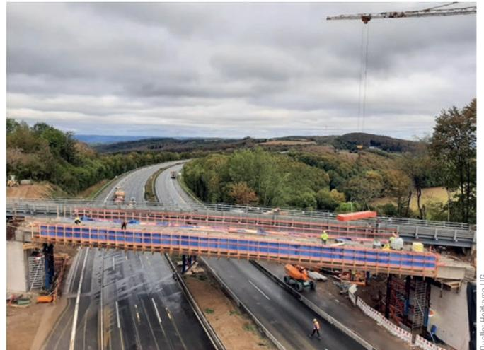
**Bild 10** Ansicht des Brückenneubaus bei Hagen im Bauzustand während der Installation der auf Hilfsjochen aufgelagerten Spannbetonfertigteile
