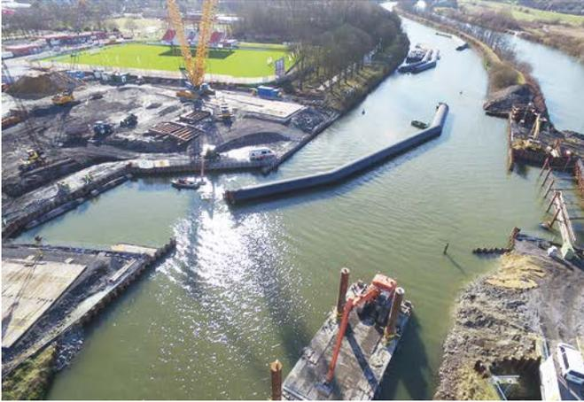
**Bild 14** Einschwimmen und Absenken der Rohre
