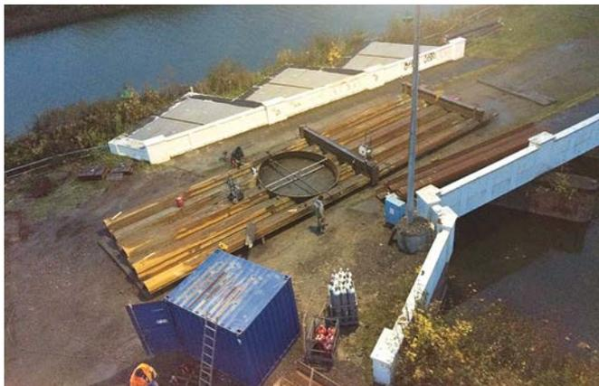
**Bild 12** Fertiggestellte Brillenwand vor Einbau in Kanal
