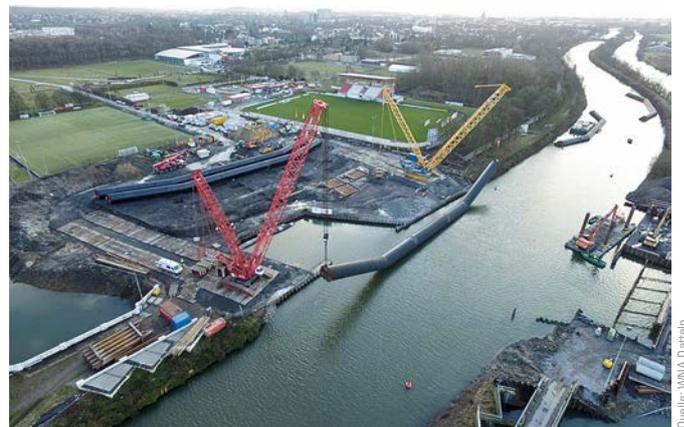
**Bild 13** Einheben der Rohre mittels Raupenkranen im Tandemhub
