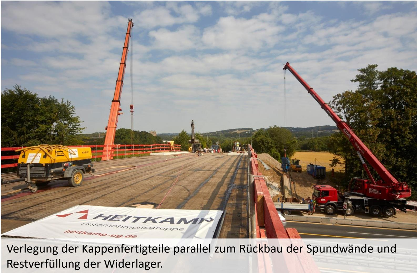
Verlegung der Kappenfertigteile parallel zum Rückbau der Spundwände und Restverfüllung der Widerlager.
