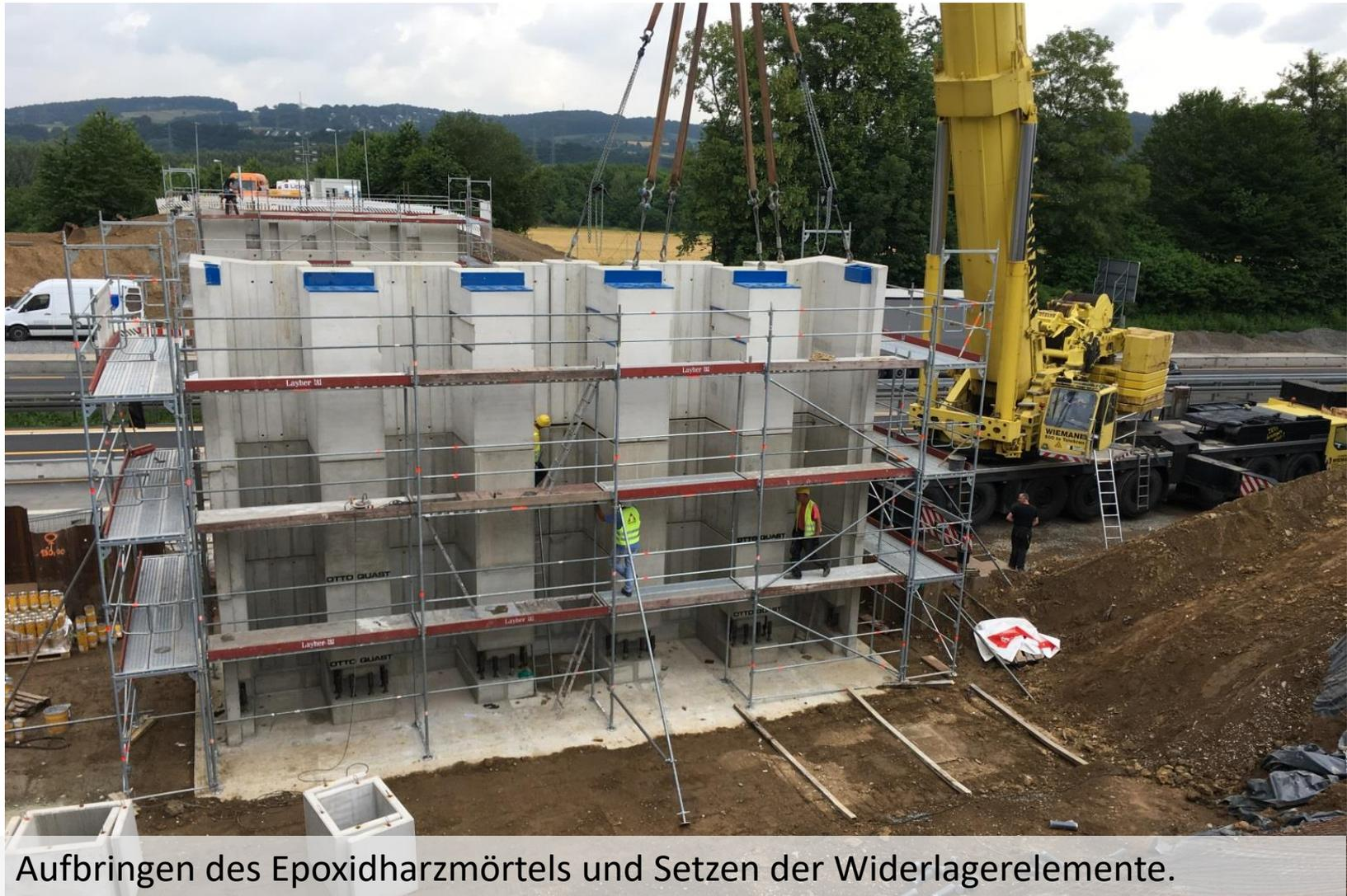
Aufbringen des Epoxidharzmörtels und Setzen der Widerlagerelemente.
