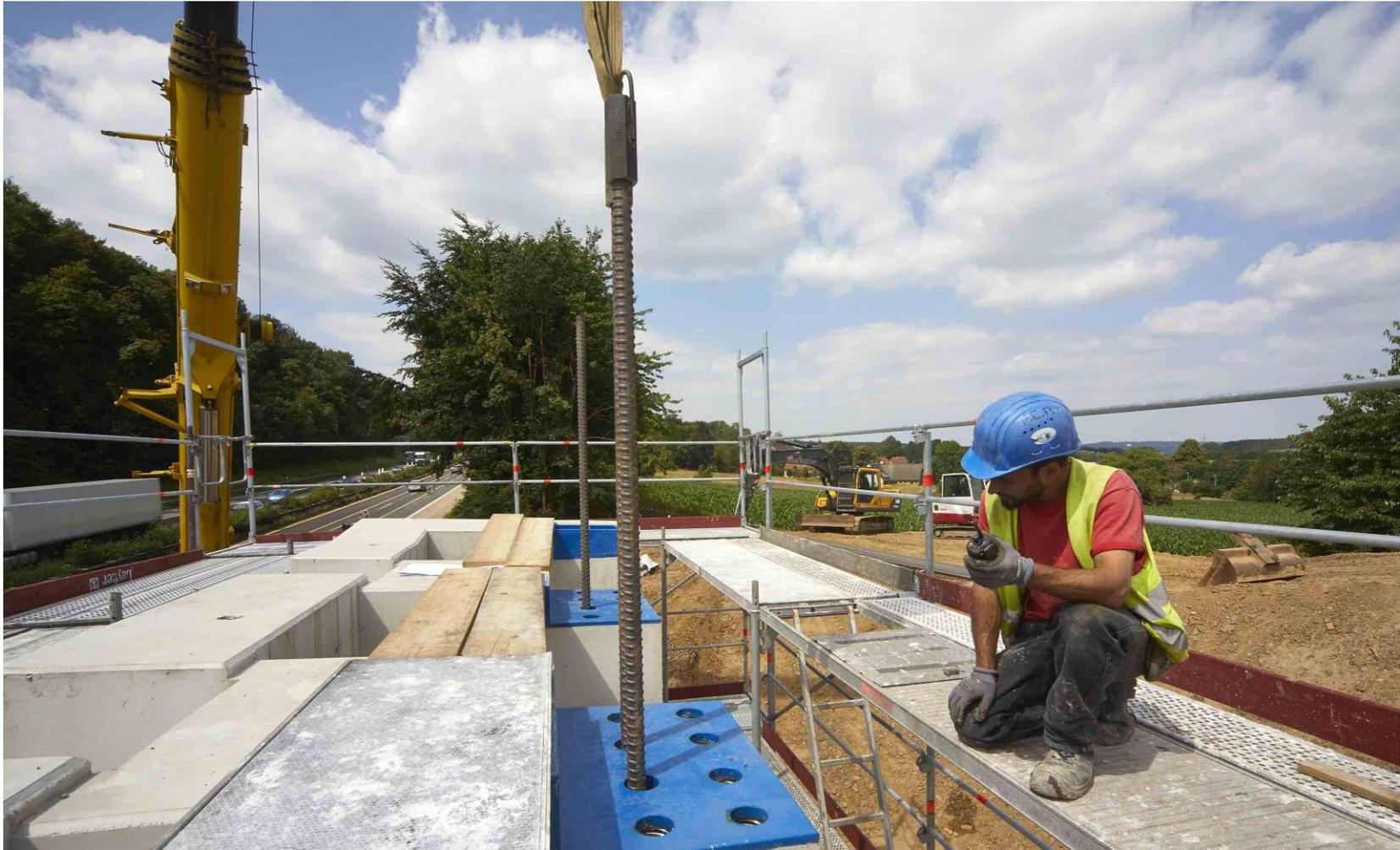
Einfädeln der 50 mm Gewis und hydraulisch mit den Fundament-Gewis koppeln.
