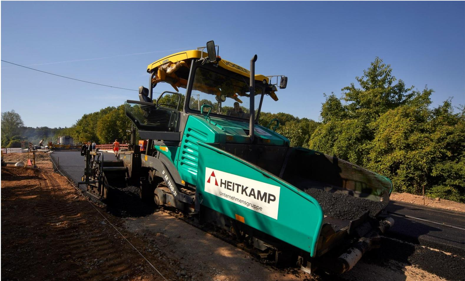
Gussasphalteinbau auf dem Bauwerk und Straßenbau auf den Rampen
