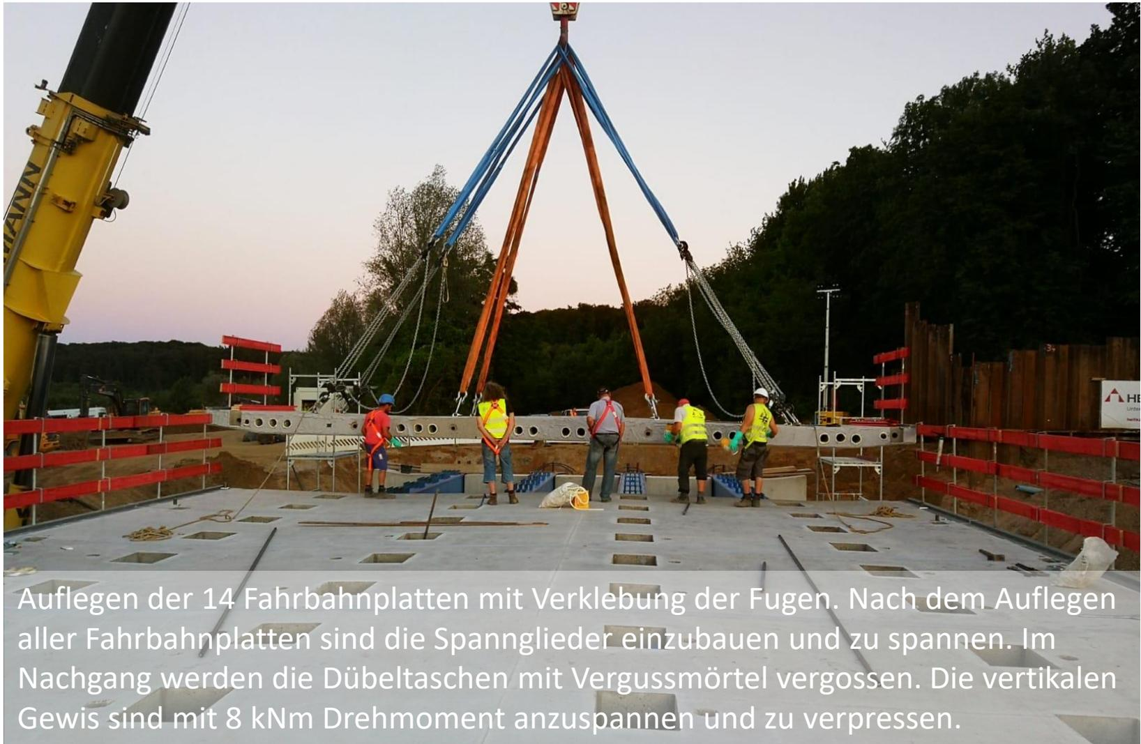
Auflegen der 14 Fahrbahnplatten mit Verklebung der Fugen. Nach dem Auflegen aller Fahrbahnplatten sind die Spannglieder einzubauen und zu spannen. Im Nachgang werden die Dübeltaschen mit Vergussmörtel vergossen. Die vertikalen Gewis sind mit 8 kNm Drehmoment anzuspinnen und zu verpressen.
