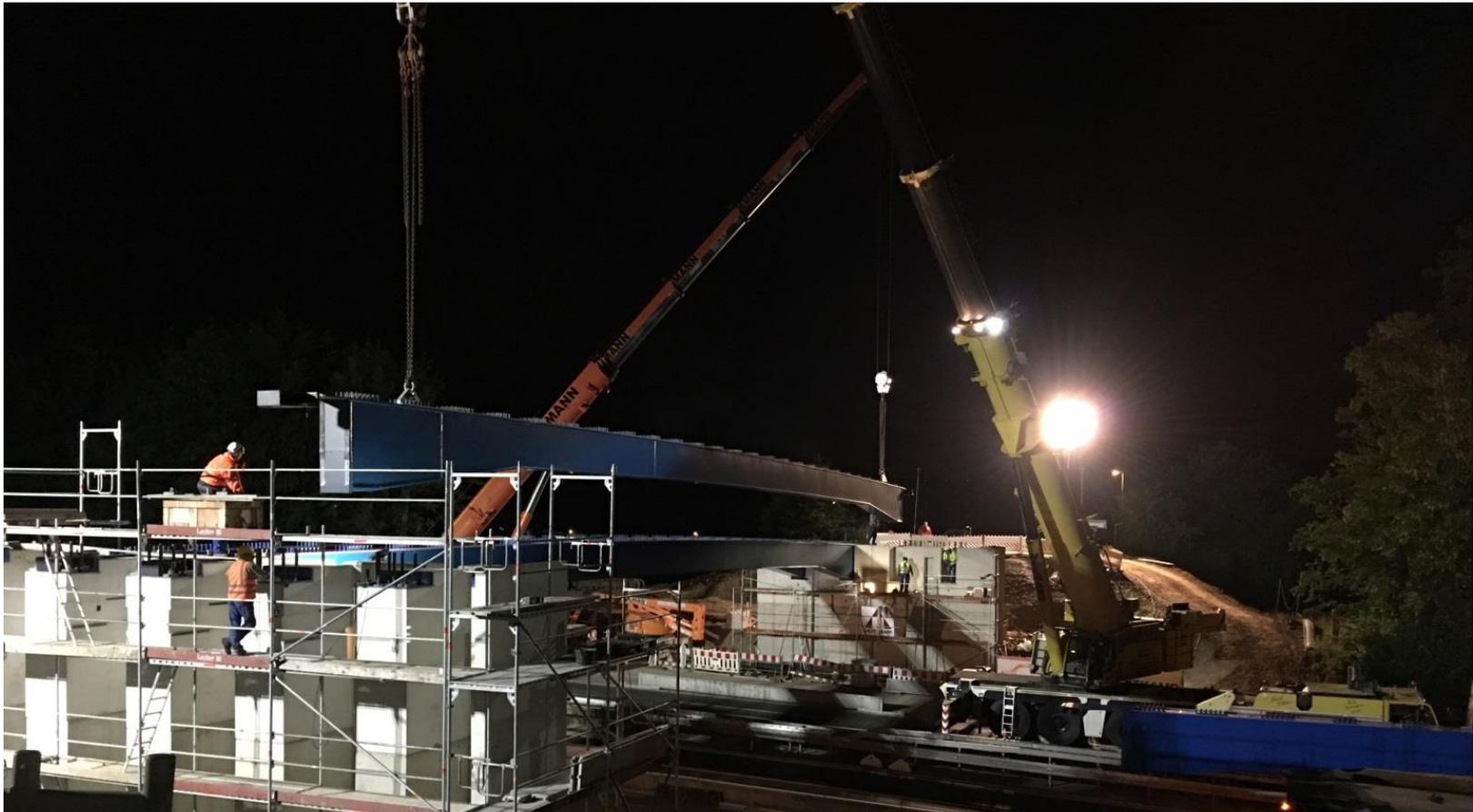
Einfädeln der „Zahnbürste“ der Stahlhohlkästen auf die 50 mm Gewis und verschrauben. Im Nachgang Herstellung der biegesteifen Rahmenecke mit Flüssigmetall und Vergussbeton.
