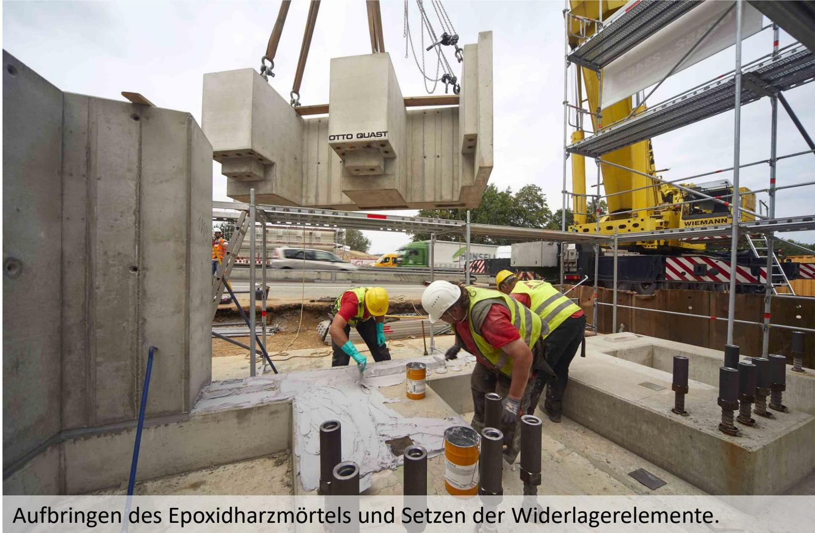
Aufbringen des Epoxidharzmörtels und Setzen der Widerlagerelemente.
