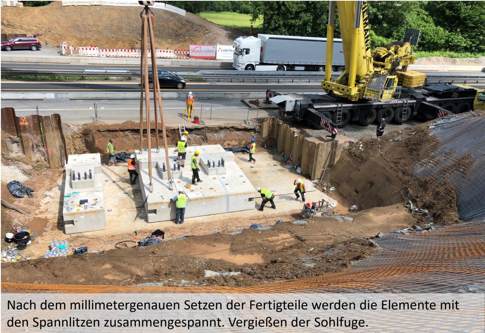
Nach dem millimetergenauen Setzen der Fertigteile werden die Elemente mit den Spannritzen zusammengespannt. Vergießen der Sohlfuge.
