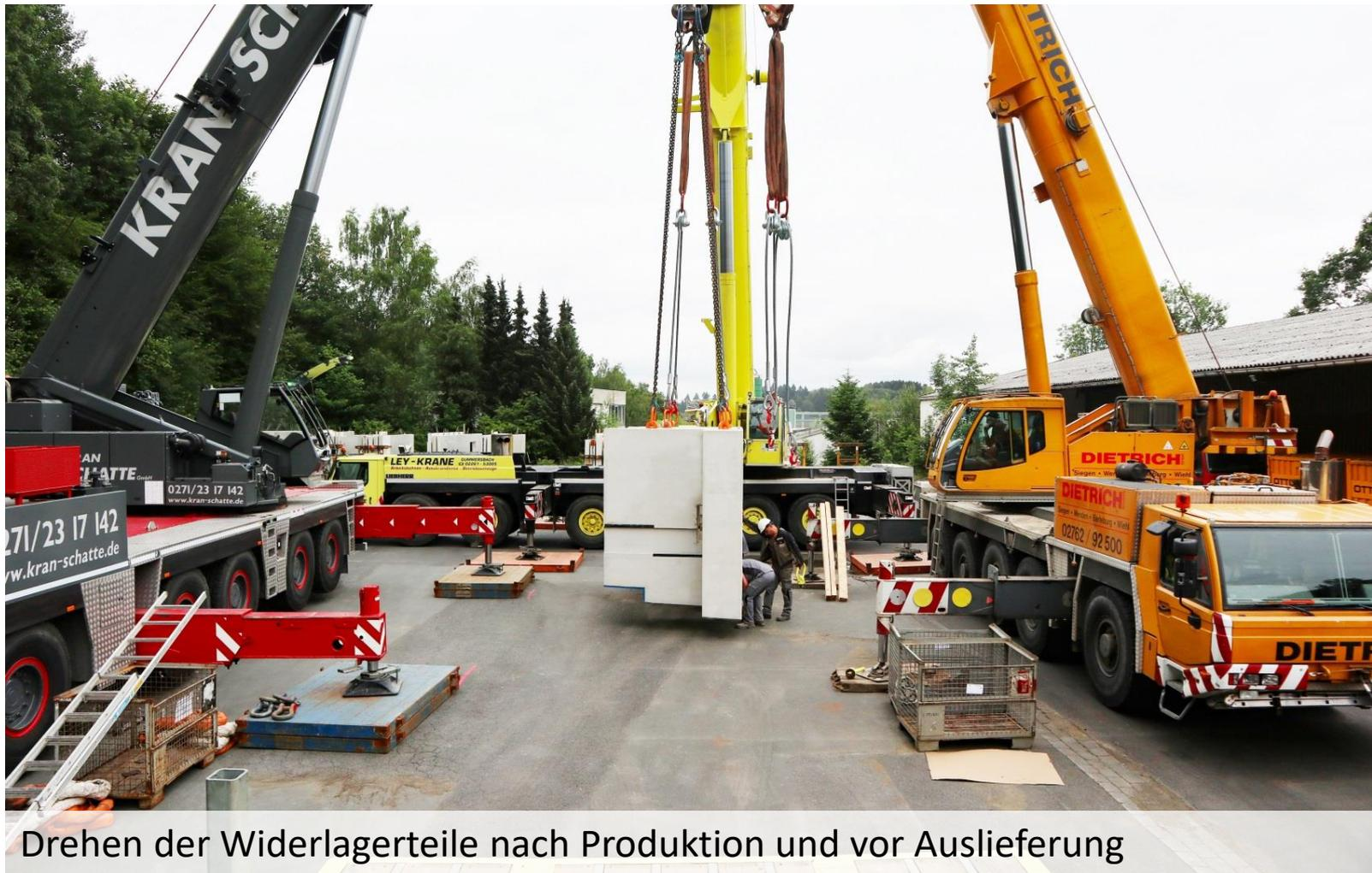
Drehen der Widerlagerteile nach Produktion und vor Auslieferung
