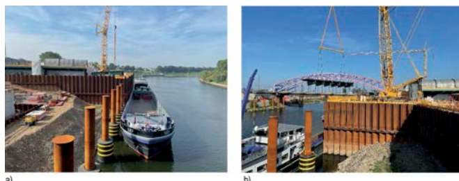
Bild 13 Umschlag von Brückensegmenten auf dem fertiggestellten Montagehafen: a) Liegeplatz am temporären Montagehafen sowie Leitwerk, b) Umschlag von Brückensegmenten auf dem fertiggestellten Montagehafen Transshipment of bridge segments on the completed assembly port: a) berth at the temporary assembly port and dolphins, b) transshipment of bridge segments on the completed assembly port
