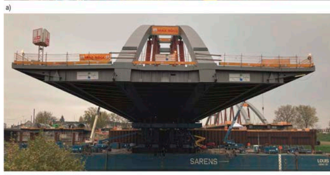
Bild 14 Blick auf a) Seiten- und b) Hauptwand bei Längsverschub der Hafencanalbrücke auf ein Schwimmponon View of the a) side and b) main wall at the longitudinal displacement of the harbour canal bridge on a floating pontoon
