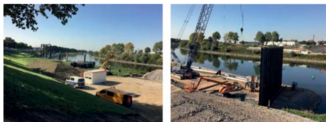
Bild 12 Ausführung der Spundwandarbeiten von Land: a) Arbeitsebene direkt an der Ruhr, b) Ausführung der Spundwandarbeiten Execution of sheet piling works from land: a) working level directly on the Ruhr, b) execution of sheet piling works
