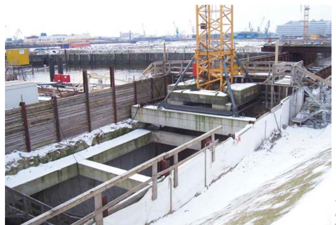
Bild 3 Bau der U-Bahn-Trasse U4 in einer Trogrube (Foto aus 2004) Construction of the subway U4 using tray excavation (picture dated 2004)
