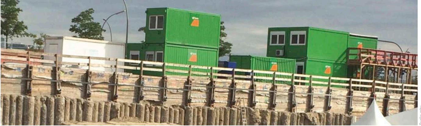
Bild 6 Baugrubenverbau in Richtung Überseeallee Building pit lining in direction Überseeallee
