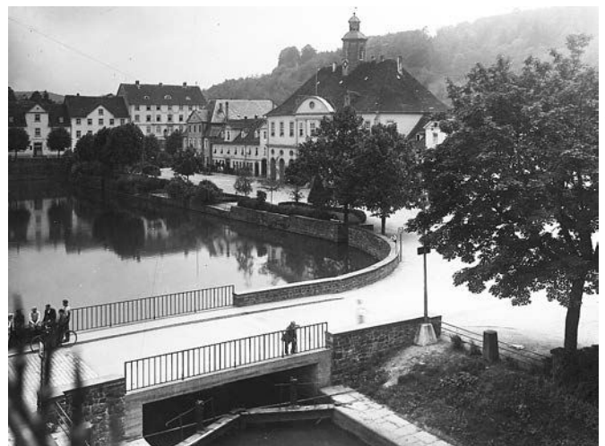
Bild 5 Rahmendurchlass bis ca. 1960er-Jahre Culvert until approx. 1960s
