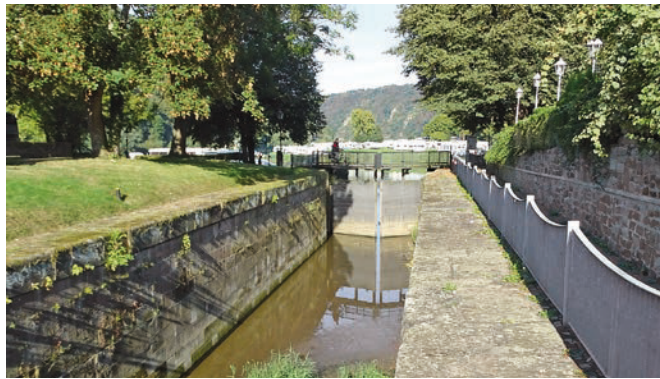
Bild 7 Bestandsschleuse heute Lock nowadays
