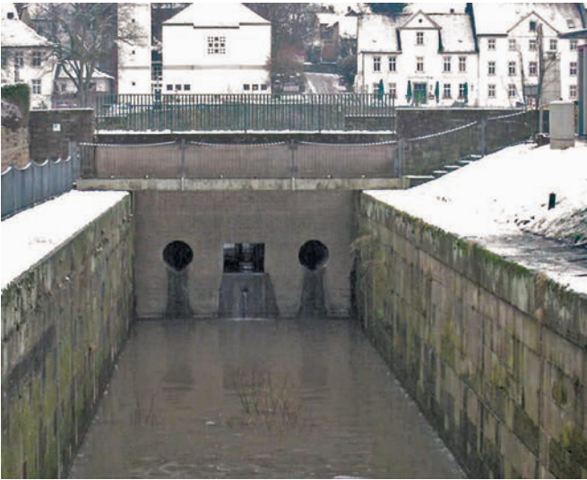
Bild 6 Rahmendurchlass heute Culvert nowadays
